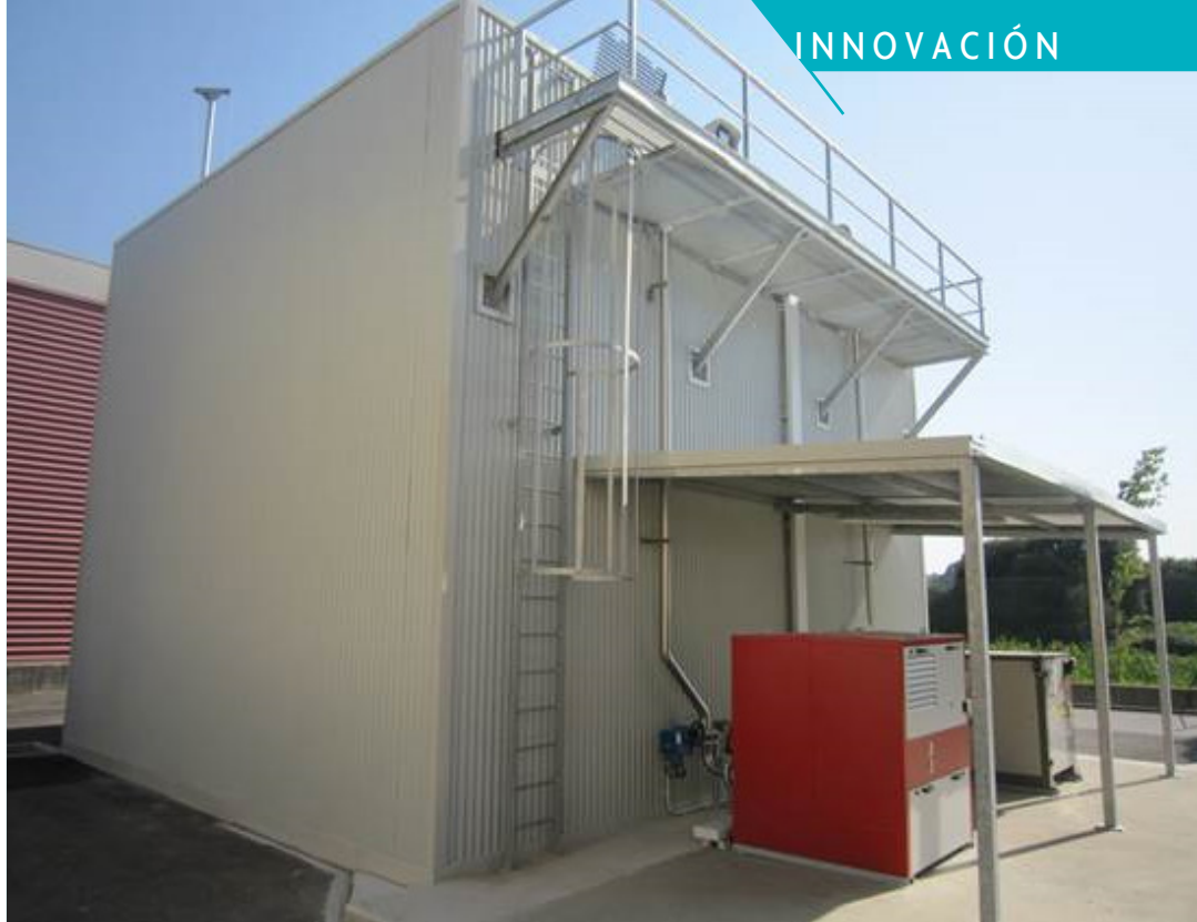
Aspecto exterior del edificio que alberga el tanque de homogeneización enterrado y los dos reactores ELAN® de los que consta el proyecto.
