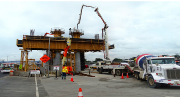
Detalle del avance de la obra.
